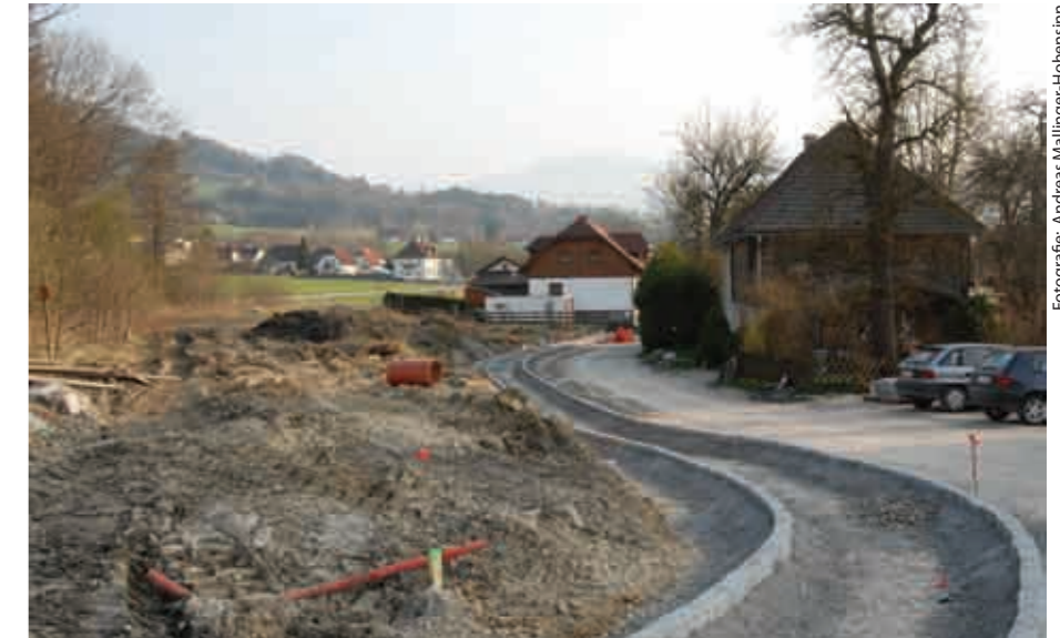
Bauarbeiten in der Schwärz
