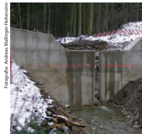
Manchmal einfach notwendig: „harte Verbauung“ zur Bändigung der Naturgewalten
